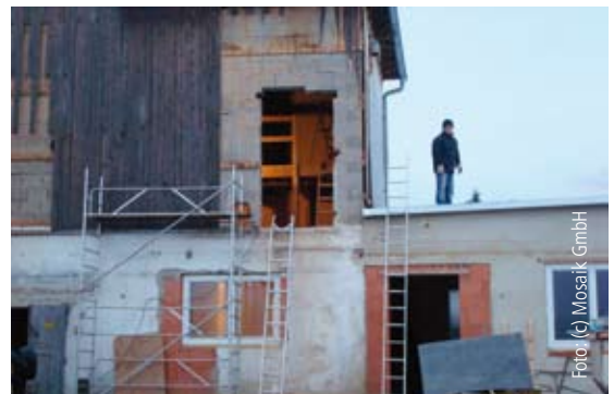
Die ehemalige Tischlerei Aldrian wird barrierefrei für die Mosaik KlientInnen umgebaut!
